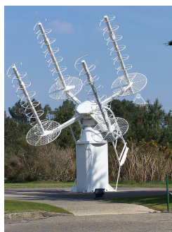
Réseau de quatre antennes hélicoïdales en mode axial 19
